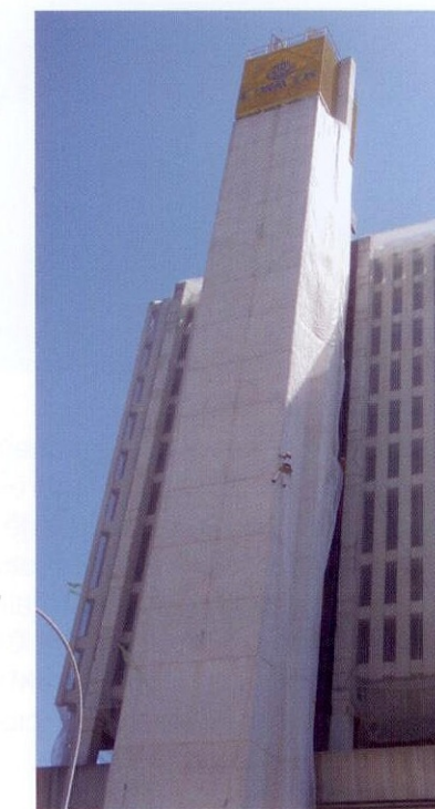
Colocación de redes
