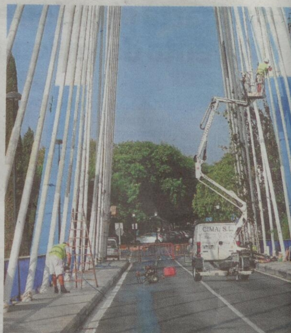
Operarios municipales limpiando los pilones del puente
